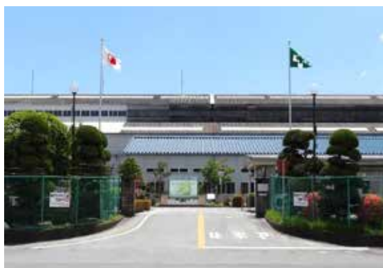
<松阪プラント正面入口>
