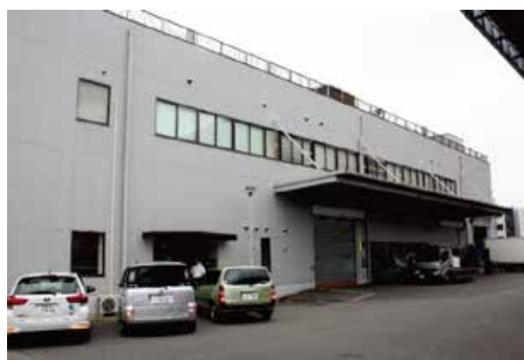
【支社家屋全景】
