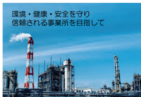
【三重地域塩浜地区プラント】
