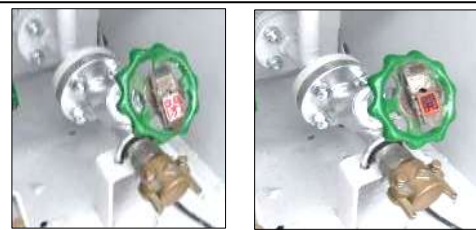
Y型弁の開閉表示 (ハンドルが逆さまになることで表示が反転する構造) ※ハンドルは何回も回転するので取扱い上では作業者が反転を確認すること。
