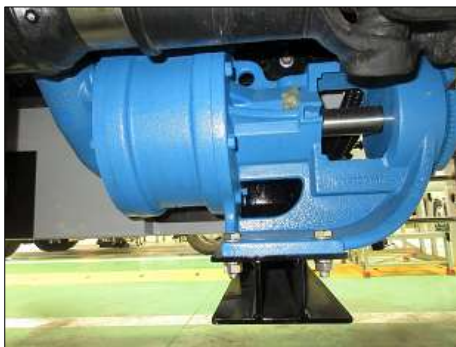
バイキングポンプ(実際に設置されている状態)
