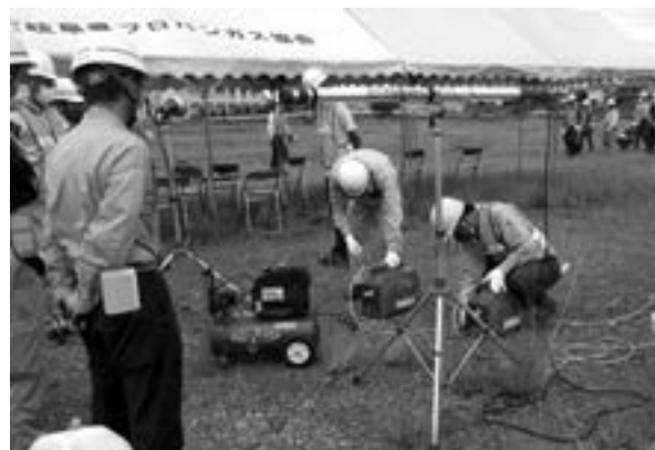
【発電機稼働訓練の様子】
