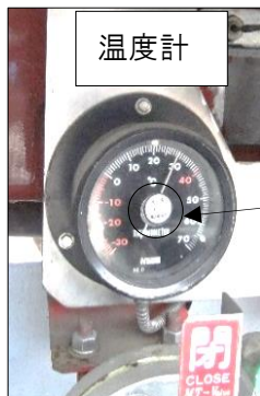
点検ステッカー (検査時に基準測定器等によりチェックされていること)
