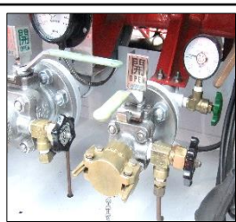
ボール弁の開閉表示 (ハンドルに開閉表示が固定されているのでハンドルを操作することで開閉が自動的に表示される。)
