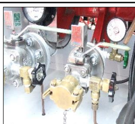
ボール弁の開閉表示 (ハンドルに開閉表示が固定されているのでハンドルを操作することで開閉が自動的に表示される。)
