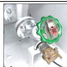
Y型弁の開閉表示 (ハンドルが逆さまになることで表示が反転する構造) ※ハンドルは何回も回転するので取扱い上では作業者が反転を確認すること。
