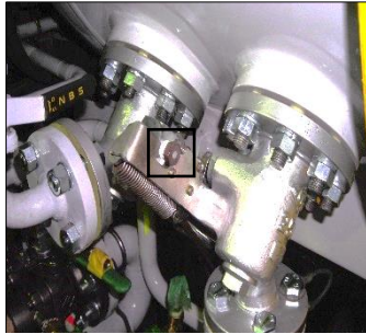
緊急遮断弁のヒューズメタル
