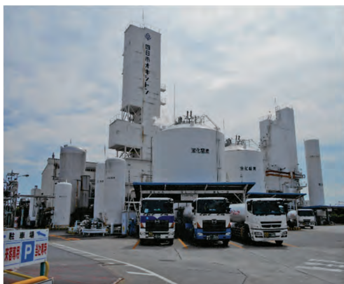
空気分離装置と液化ガス貯槽
