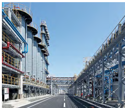
工場写真（第 2 プラント内）
