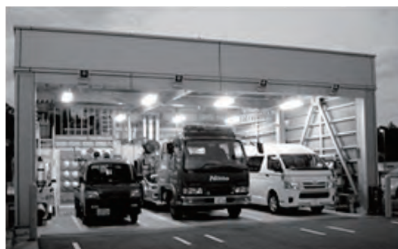
防災センター
